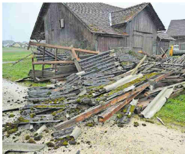
In Rothenhausen bei Weinfeldern hat der Sturm einen alten Schopf zum Einsturz gebracht. Bild: Mario Testa
