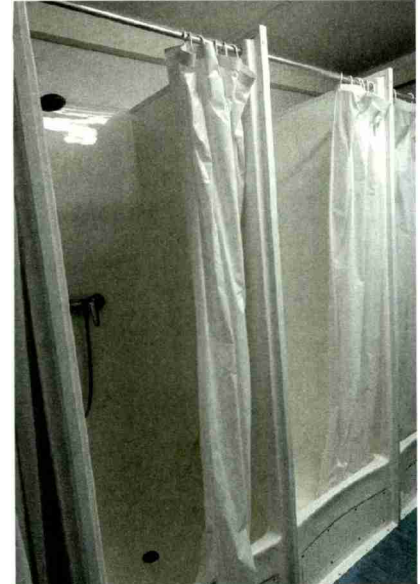
Im hinteren Bereich befinden sich die Duschen, im Mitteltrakt die Toilettenanlagen.
