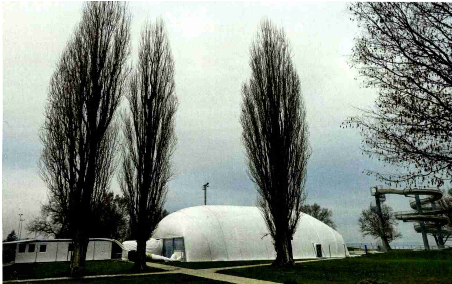
Kälte und Nebel können niemanden mehr vom Schwimmen abhalten. Die Traglufthalle überspannt das 25-Meter-Becken, links sind in mobilen Containern die Umkleide- und Sanitärbereiche untergebracht.
