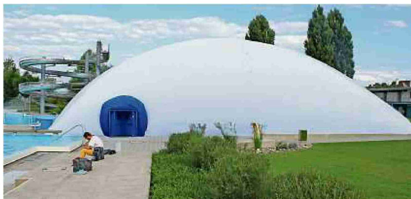
Ab Oktober soll das 25-Meter-Becken im Seebad Romanshorn mit der Traglufthalle überdacht werden.
