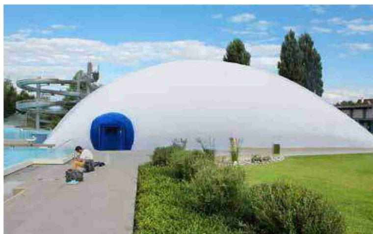
Das 25-Meter-Becken im Seebad Romanshorn wird mit einer Traglufthalle überdacht. Dieses Projekt ist für den Oberthurgau bedeutend – und es hat Strahlkraft über die Region hinaus. Die Finanzierung steht nun auf einem soliden Fundament.
